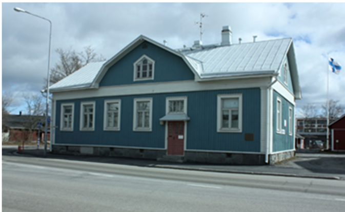
Kuva 16. Rakennusta koskee suojelumääräys sr-1.
